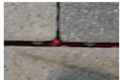
Draufsicht vor Verlegung
